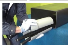
ケーブルを半割管CRKでまとめて、管路形状を構築
