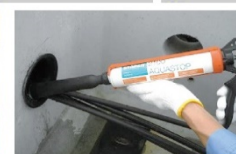
ストパックで管路内を止水し、最後は難燃モルタルで仕上げる
