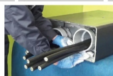
DSモルタルを半割管CRKの周りと壁面との間に充填し、開口部を閉塞
